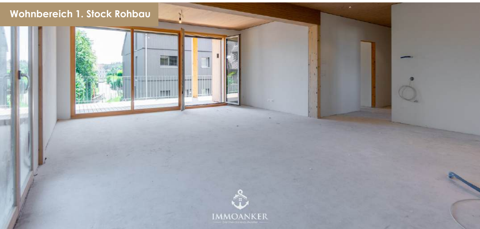
Küche 1. Stock Rohbau
